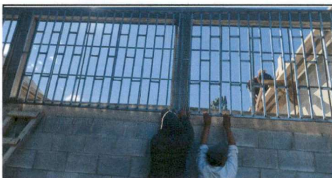
Foto 6: Sustitución de Valcones
