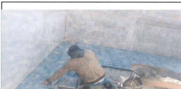
Foto 3: Sustitución de piso de torta de concreto externo
