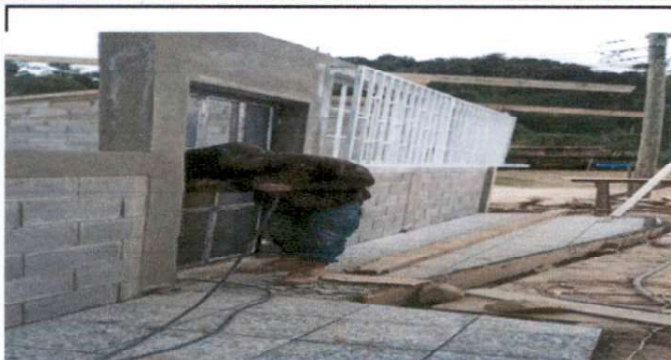
Foto1: Sustitución de puerta
