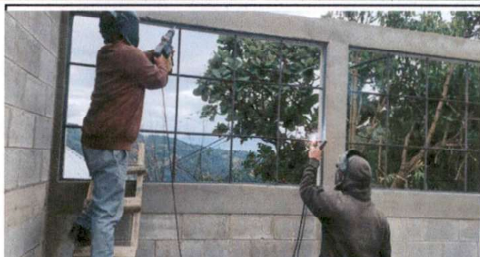
Foto 2: Sustitución de ventanas de madera por metal mas vidrio
