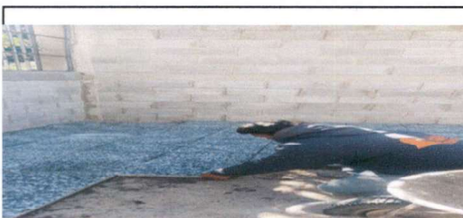
Foto 5: Sustitución de piso torta de cemesnto interno
